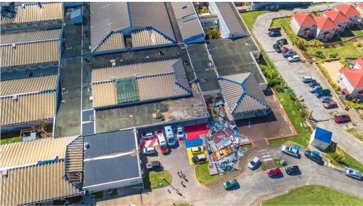
Figure 19 : Destruction du haut vent du service des urgences à Concordia (source : Agnes Etchegoyen, 2017)
