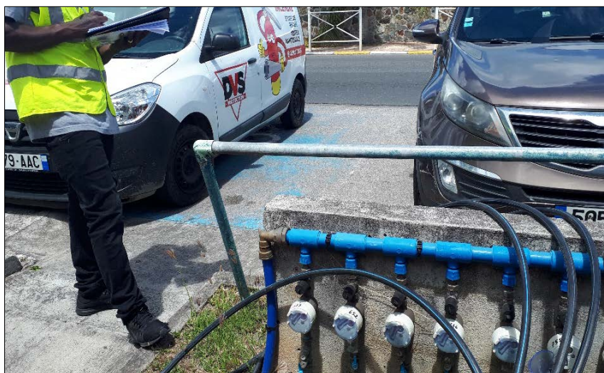
Figures 31 et 32 : relevage de compteurs d'eau rue de Sandy Ground à Mari-got. Photographies d'Amélie Latreille, mars 2019.
