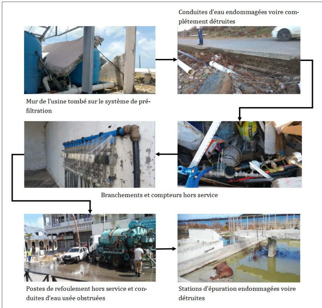
Figures 22 et 23 : l'ensemble de la chaîne des services de l'eau affectée par le cyclone. Source : Veolia, Générale des Eaux, EEASM, 2018. Photographies : EEASM, 2018. Schémas de l'auteur. ©Amélie Latreille. Publisher, 2019.
