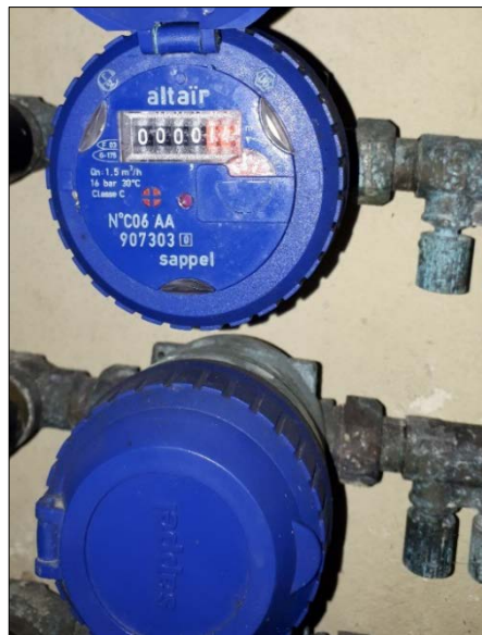
Figure 21 : un compteur d'eau équipé d'un clapet antiretour à Marigot. Photographie d'Amélie Latreille, mars 2019.
