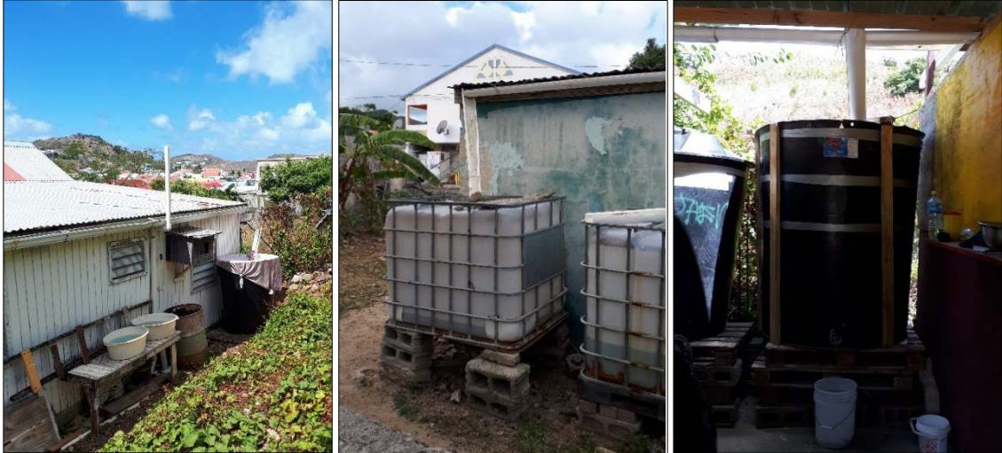
Figures 17, 18, 19 : simples cuves de récupération d'eau de pluie chez des particuliers (17 et 18) et chez un laveur de voitures (19). Photographie d'Amélie Latreille, mars 2019.
